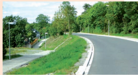
Entwässerung über die Böschungsfäche
