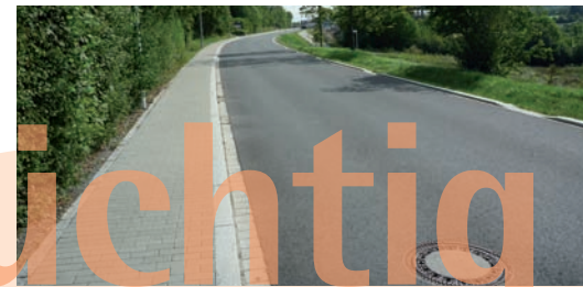
nachher Trassenverlauf mit geöffneten Bordsteinkanten zur Straßenentwässerung in die Mulden-Rigolen
